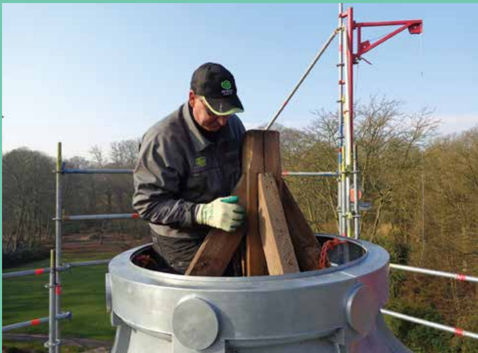
Op het dak van kasteel Pulhof. “Voor mij was dit een van de mooiste projecten waar ik aan gewerkt hebt”, zegt Dries.
